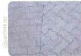
6. Juntas de Paginação (portadas com serra - Clipper)
