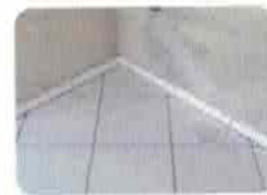
8. Detalhe de Recortes (Encontros, bordos e raios)
