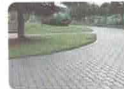
9. Intertravado Assentado (Fck = 35MPa, h=8cm)
