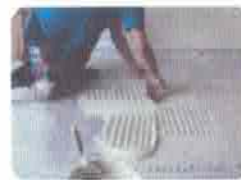
3. Espalhar Argamassa (Desempenadeira dentada)
