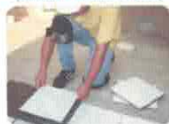
4. Assentar Peças (Auxílio Martelo de Borracha)
