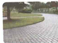
9. Intertravado Assentado (Fck = 35MPa, h=8cm)
