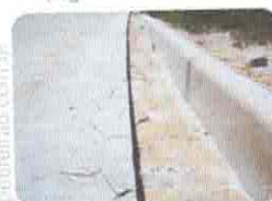
5. Cortes de Acabamento (sarjetas, meia cana, meio fio)
