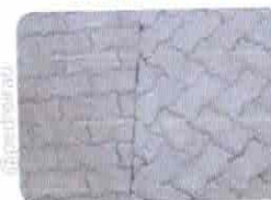
6. Juntas de Paginação (cortadas com serra Clipper)
