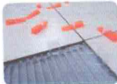
5. Utilizar Espaçadores (Foto: espaçador e nivelador)
