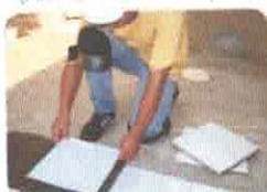
4. Assentar Peças (Auxílio Martelo de Borracha)
