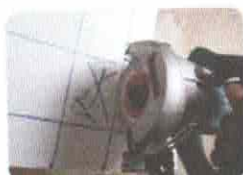
7. Furos em Peças (auxílio de Serra Mármora)
