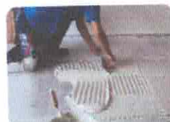
3. Espalhar Argamassa (Desempenadeira dentada)
