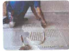
3. Espalhar Argamassa (Desempenadeira dentada)
