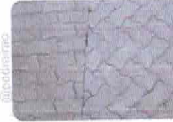
6. Juntas de Paginação (cortadas com serra Clipper)
