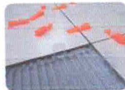
5. Utilizar Espaçadores (Foto: espaçador e nivelador)
