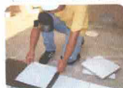
4. Assentar Peças (Auxílio Martelo de Borracha)
