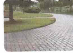
9. Intertravado Assentado (Fck = 35MPa, h=8cm)
