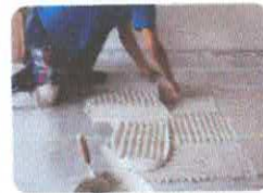
3. Espalhar Argamassa (Desempeneadeira dentada)
