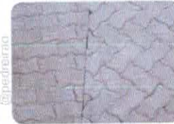
6. Juntas de Paginação (cortadas com serra Clipper)
