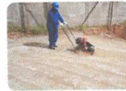
8. Salgar e Bater o Piso (areia e placa vibratória)
