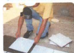
4. Assentar Peças (Auxílio Martelo de Borracha)
