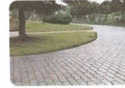
9. Intertravado Assentado (Fck = 35MPa, h=8cm)
