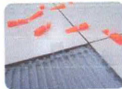
5. Utilizar Espaçadores (Foto: espaçador e nivelador)
