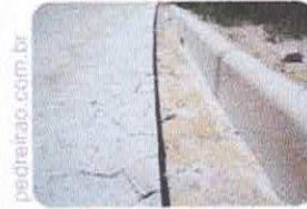
5. Cortes de Acabamento (sarjetas, meia cana, meio fio)
