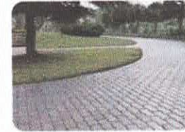
9. Intertravado Assentado (Fck = 35MPa, h=8cm)
