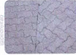
6. Juntas de Paginação (cortadas com serra Clipper)
