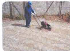
8. Salgar e Bater o Piso (areia e placa vibratória)
