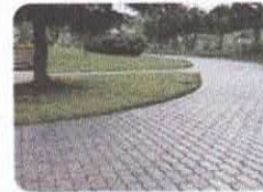
9. Intertravado Assentado (Fck = 35MPa, h=8cm)
