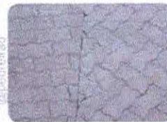
6. Juntas de Paginação (cortadas com serra Clipper)
